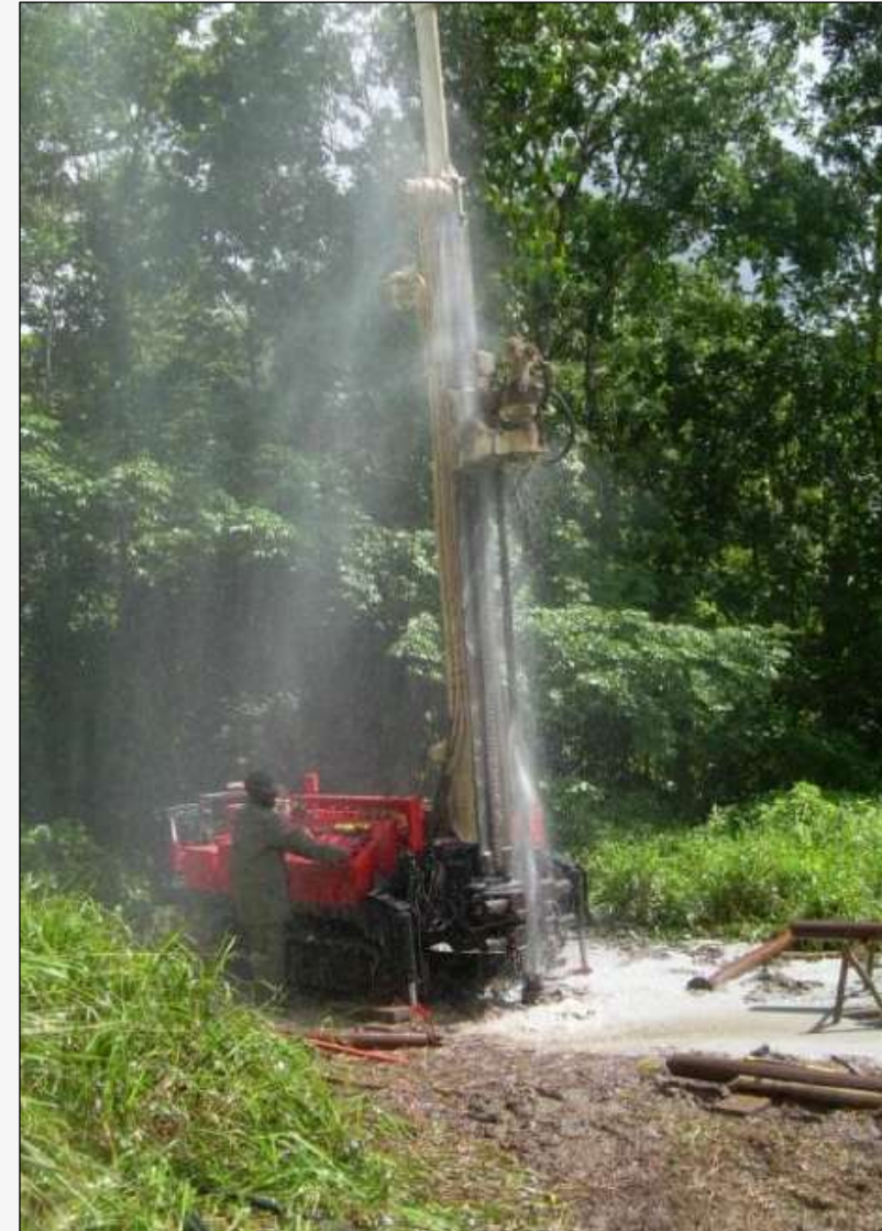
Exemple d'un chantier de forage d'eau
