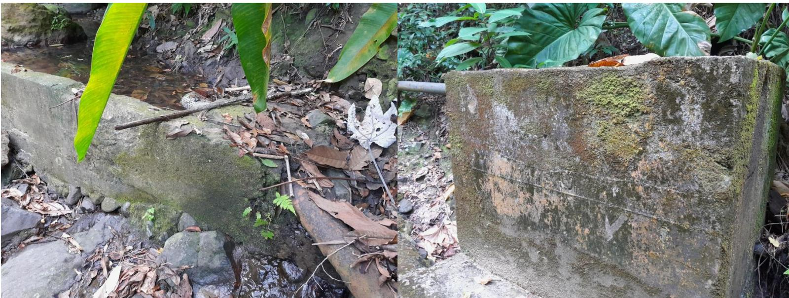
Captage de l'eau via un barrage puis stockage vers une cuve en béton
